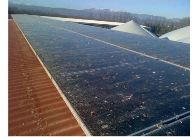
En las imágenes puede ver algunos ejemplos de instalaciones que muestran la importancia de la limpieza de los paneles solares. La suciedad y las manchas persistentes pueden provocar daños graves en toda la instalación.
